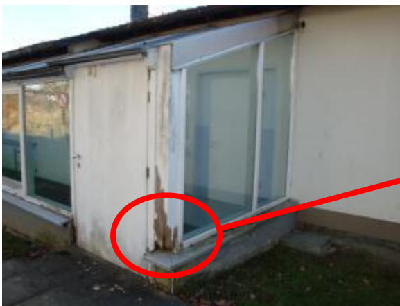
Abbildung 5-5: Durchgefallener Holzbalken GGS Berkenroth
