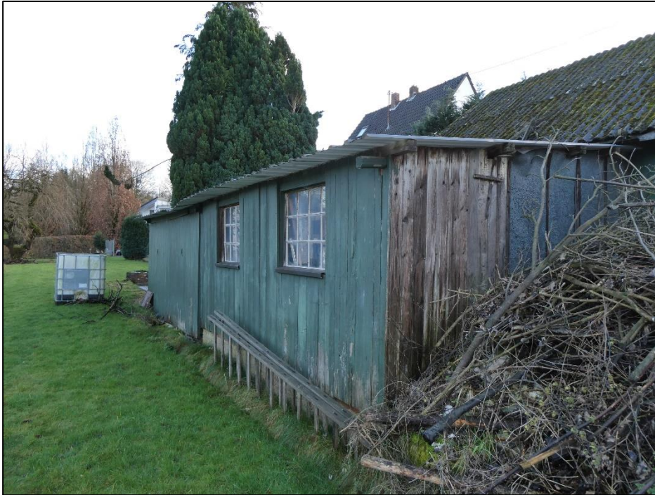
Abb. 8: Blick von Westen auf einen der Holzschuppen
