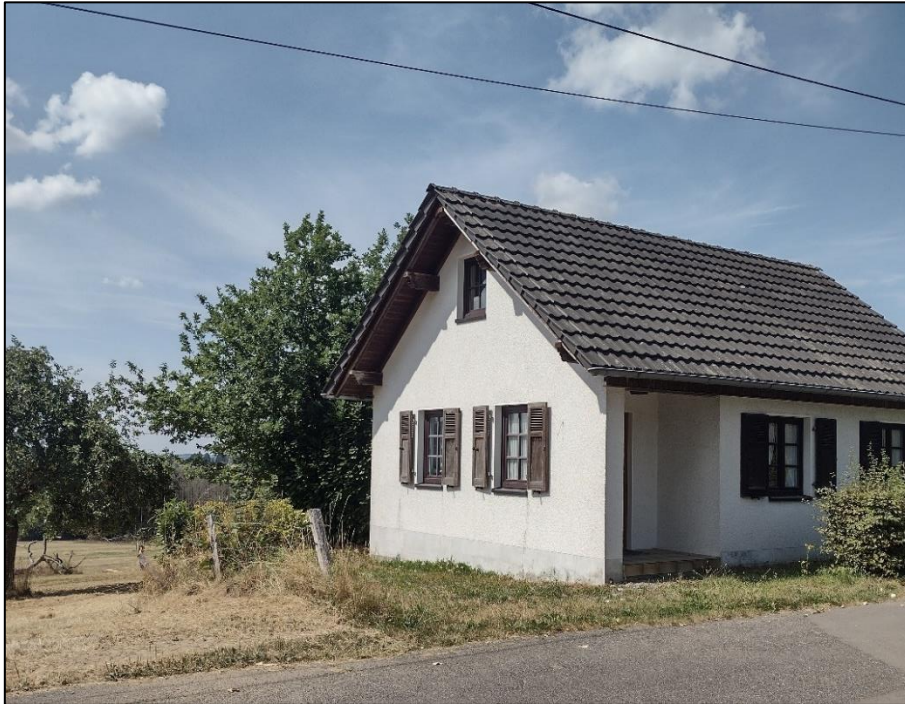
Abb. 2: Sicht auf das bestehende Gebäude im Plangebiet.
